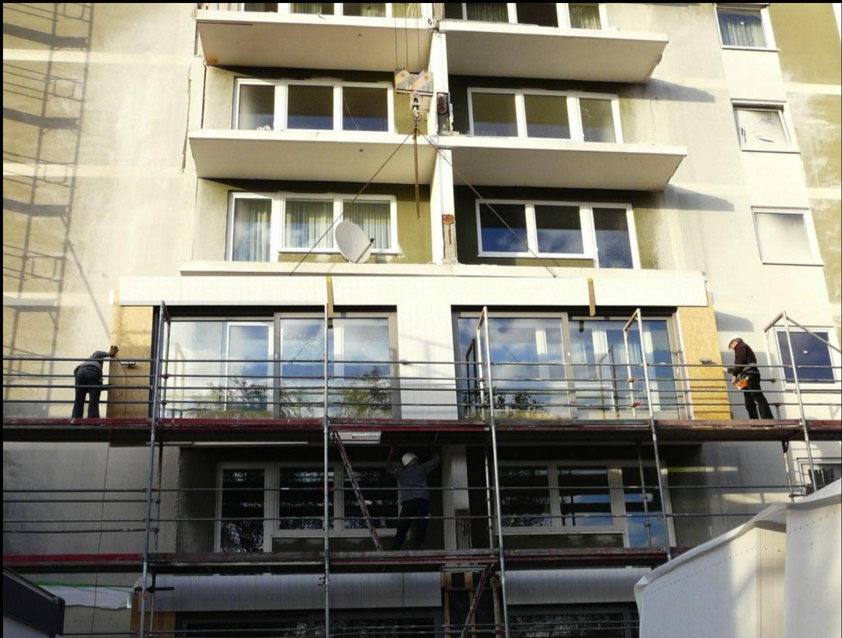
Sanierung Grüntenstraße, Augsburg. lattke architekten, bauart
