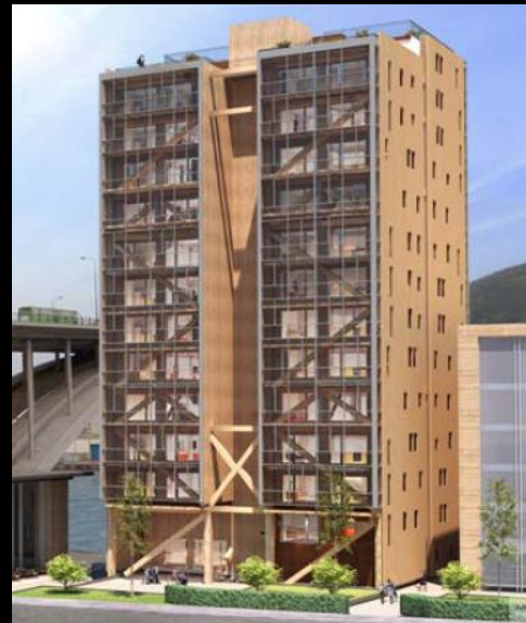
Geplantes 14 stöckiges Gebäude in Bergen, Norwegen. Konstruktion: Module und Fachwerk BSH Norwegian Wood. Picture: bob/artec/sweco
