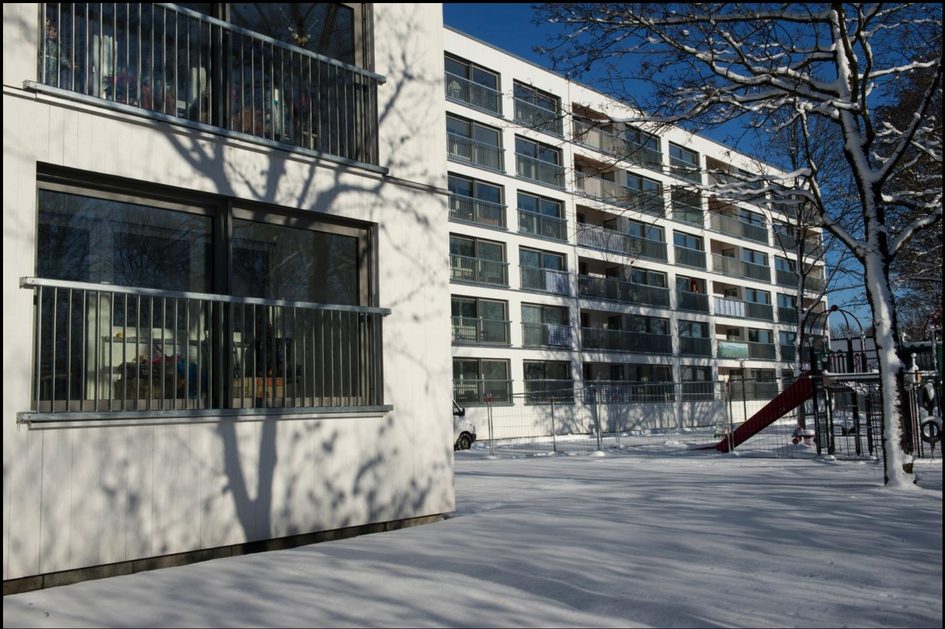
Sanierung Grüntenstraße, Augsburg. lattke architekten, bauart
