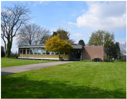
Blick auf die KiTa
