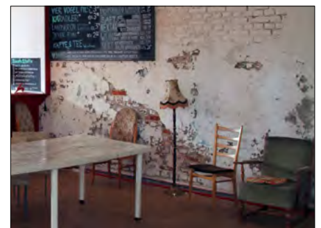
Trotz Schädigung nutzbarer rudimentärer Wandputz in Café/Kantine OSTRALE Dresden
