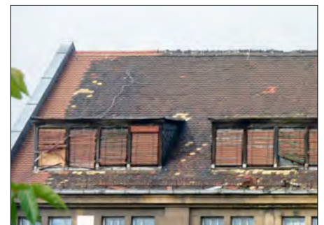
Zur Substanzsicherung giebelseitig verbesserte Biberschwanzdeckung
