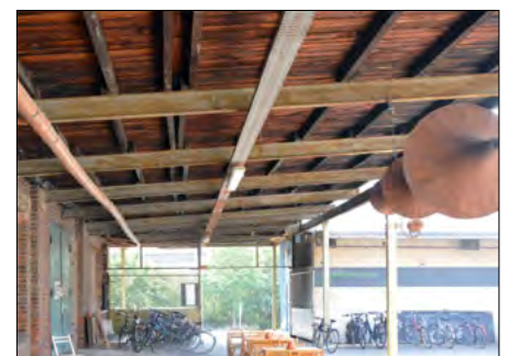
Stahlträgerkonstruktion eines Vordachs im Tapetenwerk Leipzig
