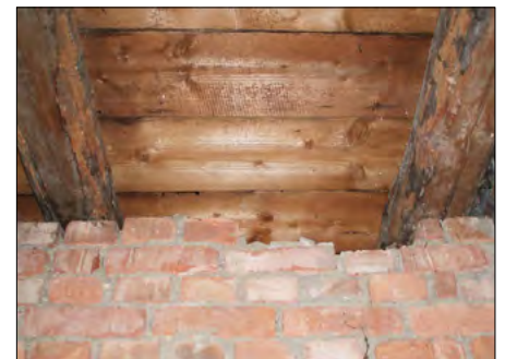
Holzbalkendecke ohne Füllung und Schalung
