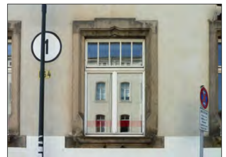
Kastenfenster in Verwaltungsgebäude mit Jugendstilfassade – Baumwollspinnerei Leipzig
