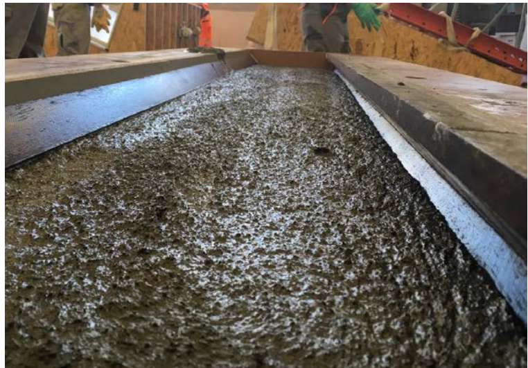
Abbildung: 3-1: Schalung für einen Schaumkern mit Transportankern (links), und eingefüllter Schaumbeton beim Auftreiben (rechts).
