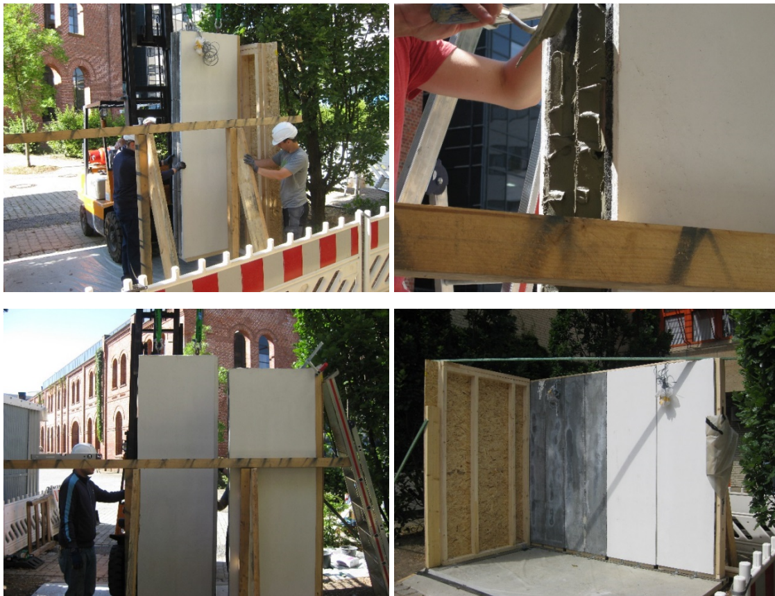
Abbildung 3-11: Montieren des ersten Wandelements der Nordwand (oben links), Fugenvermörtelung (oben rechts), Setzen des zweiten Wandelements (unten links) und Abstützung des Bauzustands am ersten Tag (unten rechts).
