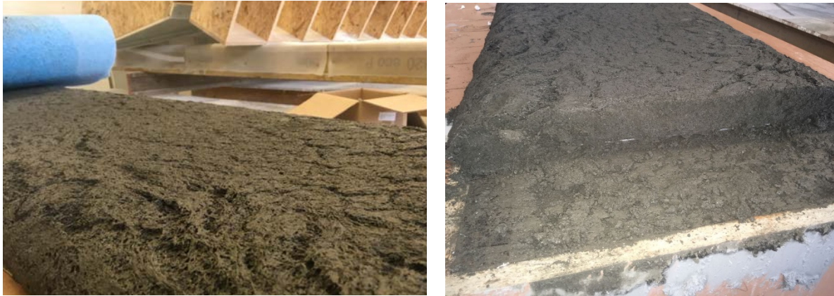
Abbildung 3-2: Maximale Treibhöhe des Schaumbetonkerns (links) und Abtragen des übergequollenen Betons (rechts).
