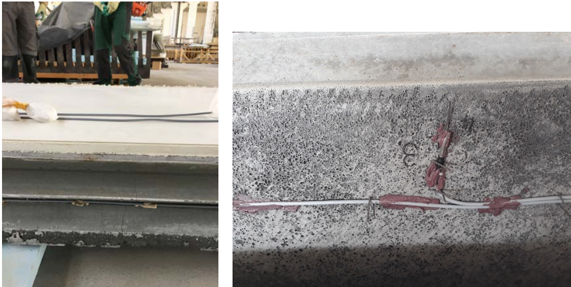
Abbildung 3-4: Wandelement mit Vorsatzschale und Temperatursensor (links), Kabelführung vor Betonage (rechts)
