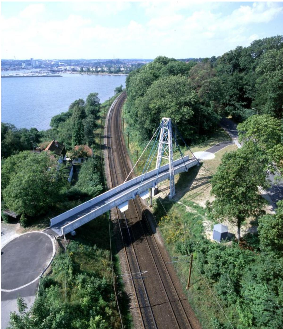
Abb. 1.5: Fußgänger- und Fahrradbrücke aus GFK-Profilen in Kolding, Dänemark, 1997; Länge: 40 m, Tragfähigkeit: 500 kg/m<sup>2</sup>, Fahrzeuge bis 5 Tonnen, Fertigstellung: 18 Stunden in drei Nächten.
