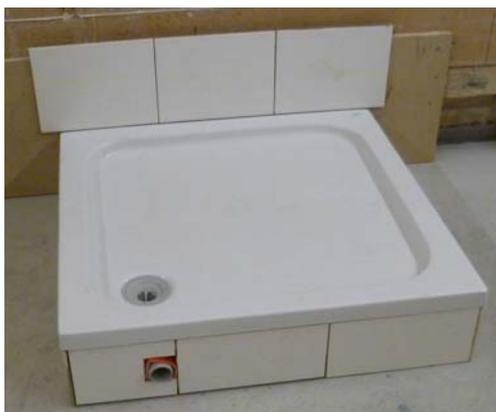
**Abb. 33:** Duschwanne mit Wannenträger (DW1 a. WT) auf der Holzbalkendecke. Die Montage erfolgte auf dem vorhandenen schwimmenden Estrich, wobei der Wannenträger direkt (d. h. ohne elastische Unterlage) auf den Estrich aufgeklebt wurde.
