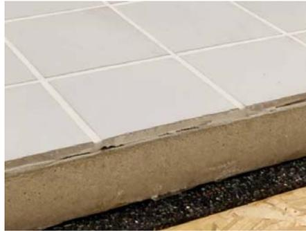
**Abb. 25:** Aufbau der Gefälleplatte mit elastischer Unterlage (GP m. U.) von der Seite her gesehen. Von oben nach unten sind in dem gezeigten Bildausschnitt die Fliesen, die Gefälleplatte aus Polystyrol-Hartschaum sowie (mit etwas seitlichem Überstand) die als elastische Unterlage verwendete Gummigranulatmatte zu erkennen.
