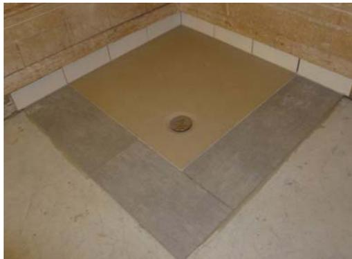
**Abb. 31 :** Bodenebene Duschfläche BD2 auf der Holzbalkendecke (Montage in einer Aussparung des auf der Decke verlegten schwimmenden Estrichs). Die Duschfläche besteht aus einer fugenlosen Mineralwerkstoffplatte, die bis zur umgebenden Umrandung aus grauen Fliesen reicht.
