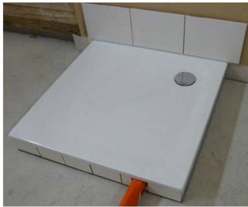
**Abb. 37:** Duschwanne DW3 in fertig eingebautem und verfliesem Zustand. Die dargestellte Montage erfolgte auf dem schwimmenden Estrich der Holzbalkendecke.
