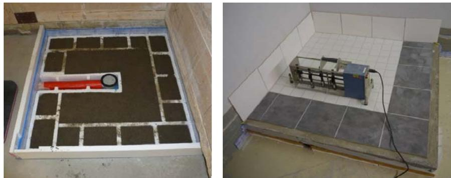
**Abb. 30:** Verfüllung des Schalungselements der Duschfläche BD1 m. U. mit Estrichbeton (linkes Bild). Im rechten Bild ist die fertige Duschfläche (weiß verflieser Bereich) auf der Massivdecke zu sehen. Die Montage auf der Decke erfolgte in der Aussparung eines Estrich-Teilstücks (Bereich mit grauen Fliesen).
