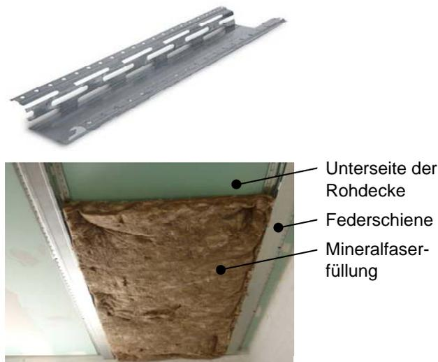
**Abb. 15:** Federschienen zur Befestigung der abgehängten Unterdecke. Im unteren Teil des Bildes sind die Schienen im eingebauten Zustand (vor Montage der unterseitigen Beplankung) zu sehen.
