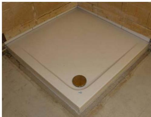
**Abb. 36:** Duschwanne DW2 in fertig eingebautem Zustand in der Aussparung des schwimmenden Estrichs.
