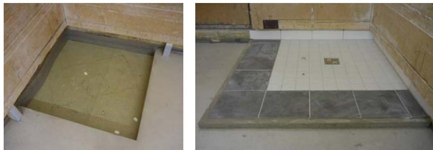
**Abb. 28:** Aussparung im vollflächigen schwimmenden Estrich auf der Holzbalkendecke (linkes Bild) und bodenebene Duschfläche BD1 o. U. in fertigem Zustand nach dem Einbau in die Aussparung (rechtes Bild). Die Duschfläche umfasst hierbei nur den mit weißen Fliesen belegten Bereich, während die umgebenden grauen Fliesen den Bodenbelag des schwimmenden Estrichs bilden.
