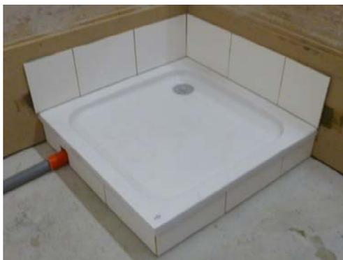
**Abb. 34:** Duschwanne mit Fußgestell (DW1 a. FG) auf der Holzbalkendecke mit schwimmendem Estrich. Im oberen Bild ist das verwendete Fußgestell, im unteren die fertig eingebaute Wanne dargestellt.
