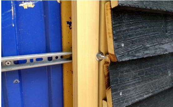
Abbildung 104 Fassadensystem: C-Schiene, Lattung, Bekleidung (hier: Stülp-schalung)
