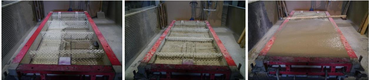
Abbildung 95: Schichtweise Herstellung der Sandwichwand: Herstellung der unteren Deckschicht (links), Herstellung des Dämmkerns aus Aerogelbeton (Mitte) und Herstellung der oberen Deckschicht (rechts)
