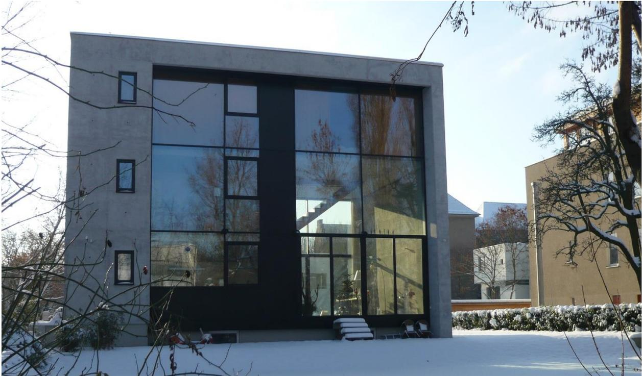
Abbildung 3: Einfamilienhaus aus Infraleichtbeton [10]
