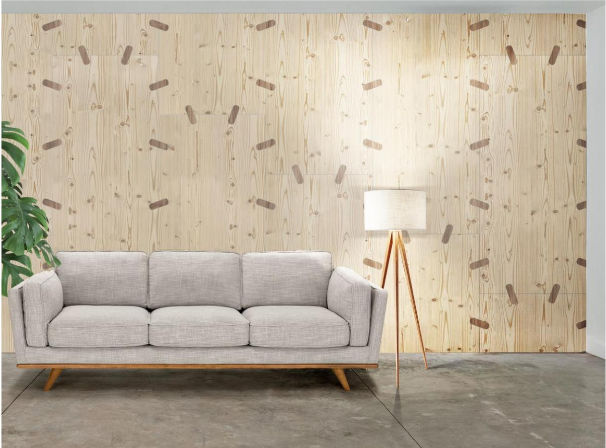
Abbildung 23: Bei Innenwänden können die Wandtafeln aus Brettsperrholzresten unverkleidet und sichtbar eingesetzt werden
