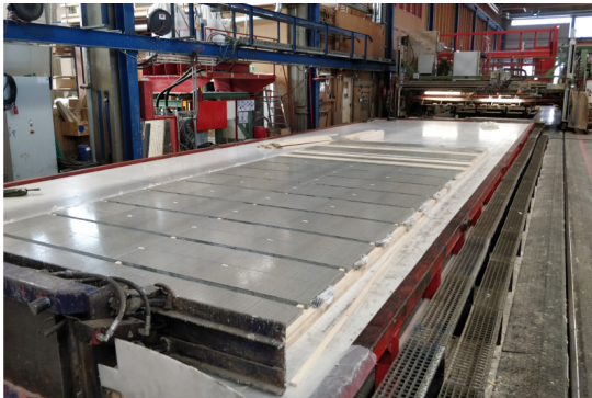
a) Eingelegte Betonplatten mit Klebstoffauftrag
