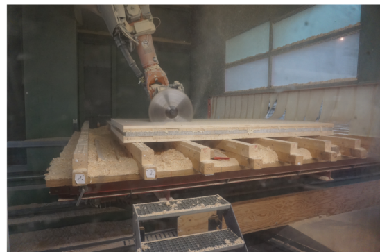
h) CNC gesteuerter Zuschnitt
