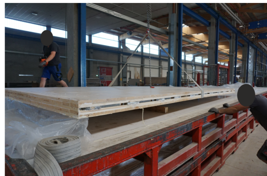
f) Ausheben des Elements
