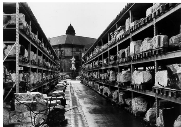
Bild 16 Lagerplätze bei der Enttrümmerung [11]
