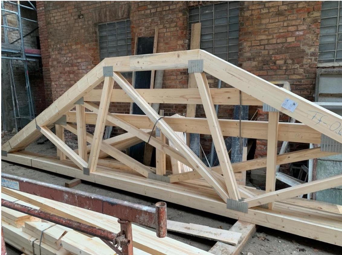
Abb. 46 Holzbinderkonstruktion
