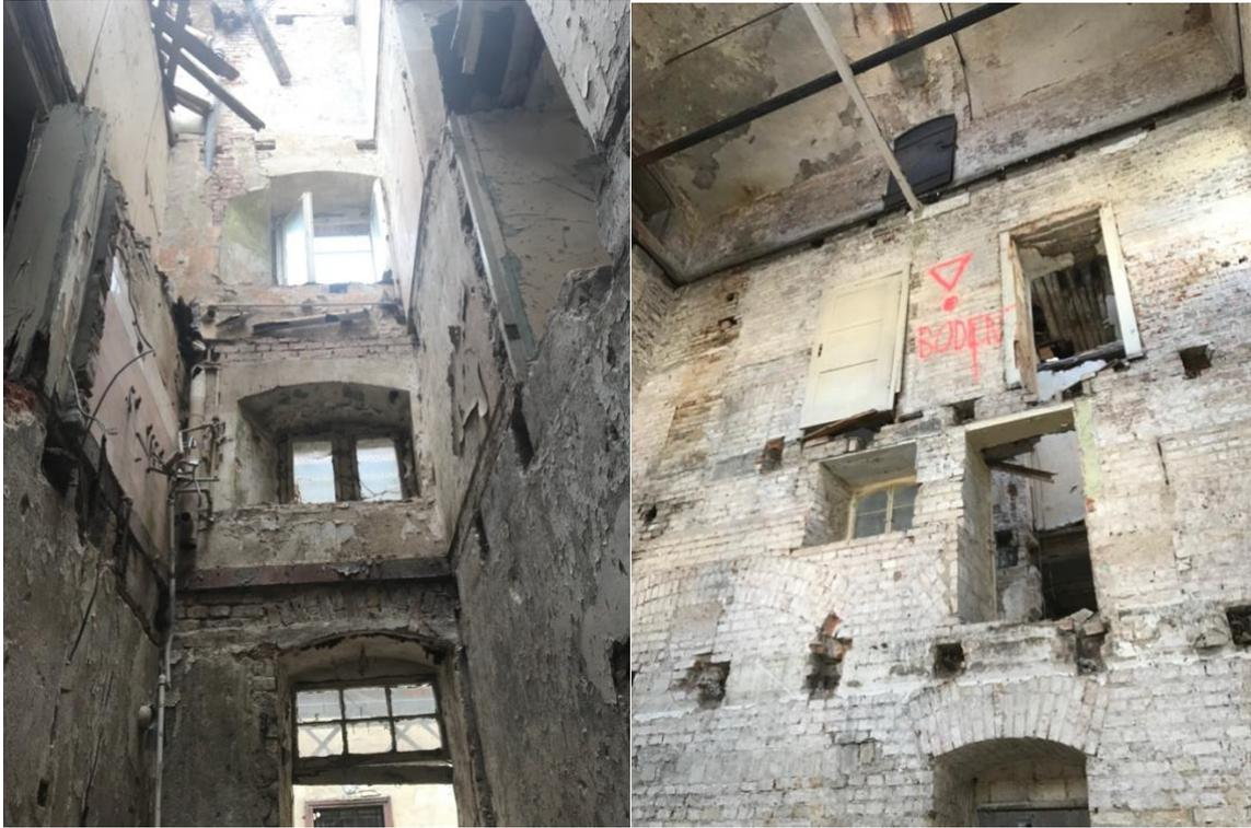
Abb. 32 Entkernung der Zwischendecken Haus 3 und 4
