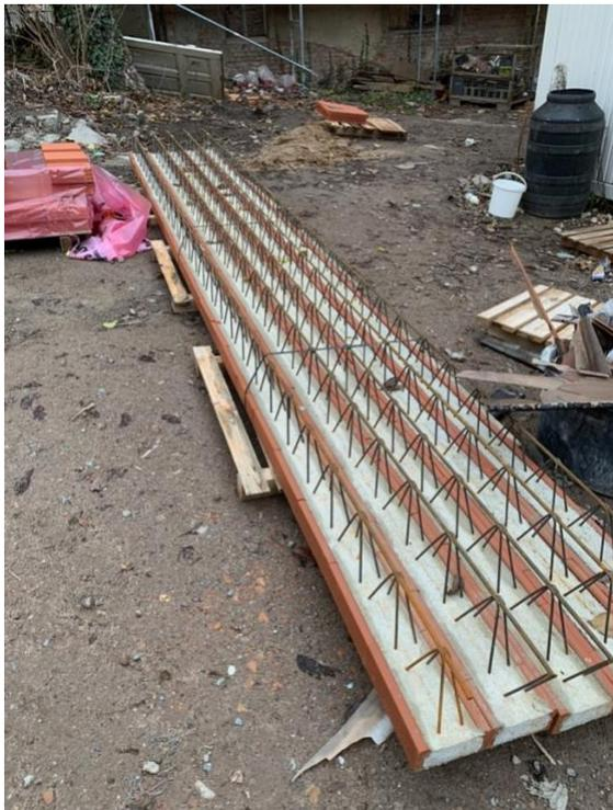
Abb. 44 Ziegel-Rippen-Decken vor Montage
