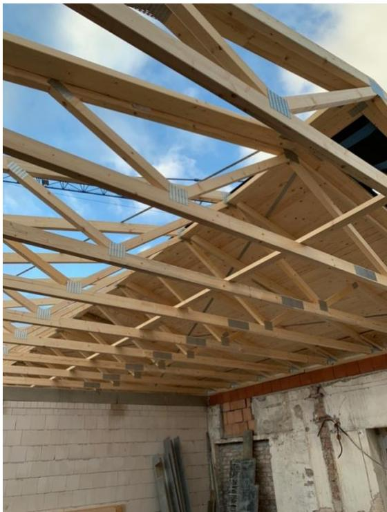
Abb. 47 Holzbinderkonstruktion
