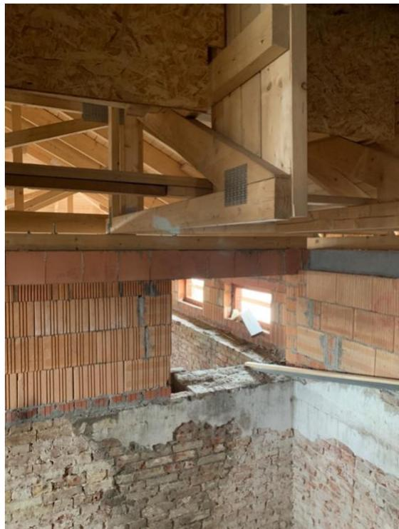
Abb. 48 Holzbinderkonstruktion
