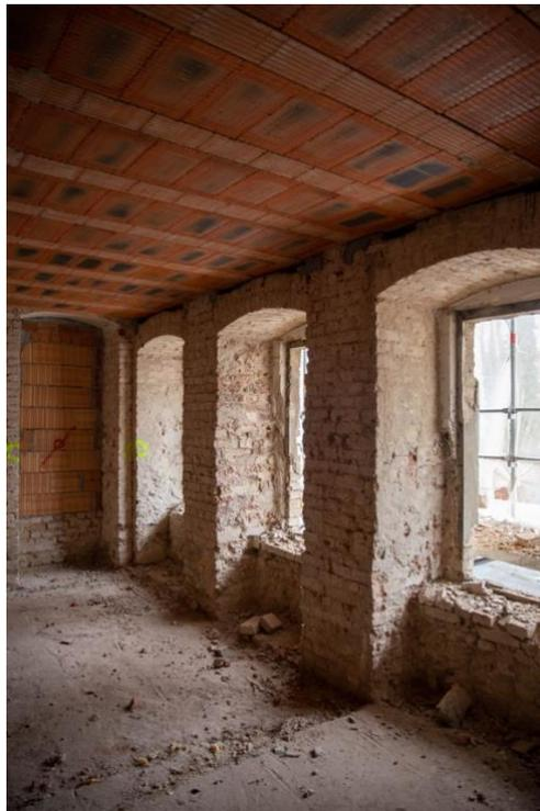
Abb. 45 Ziegel-Rippen-Decken nach Montage
