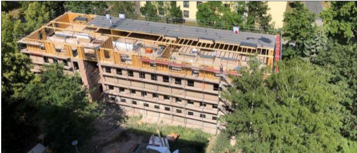
Abbildung 1 Blick aus der ehemaligen Zahnklinik, Neubau Dachgeschoss in Holzständerbauweise
