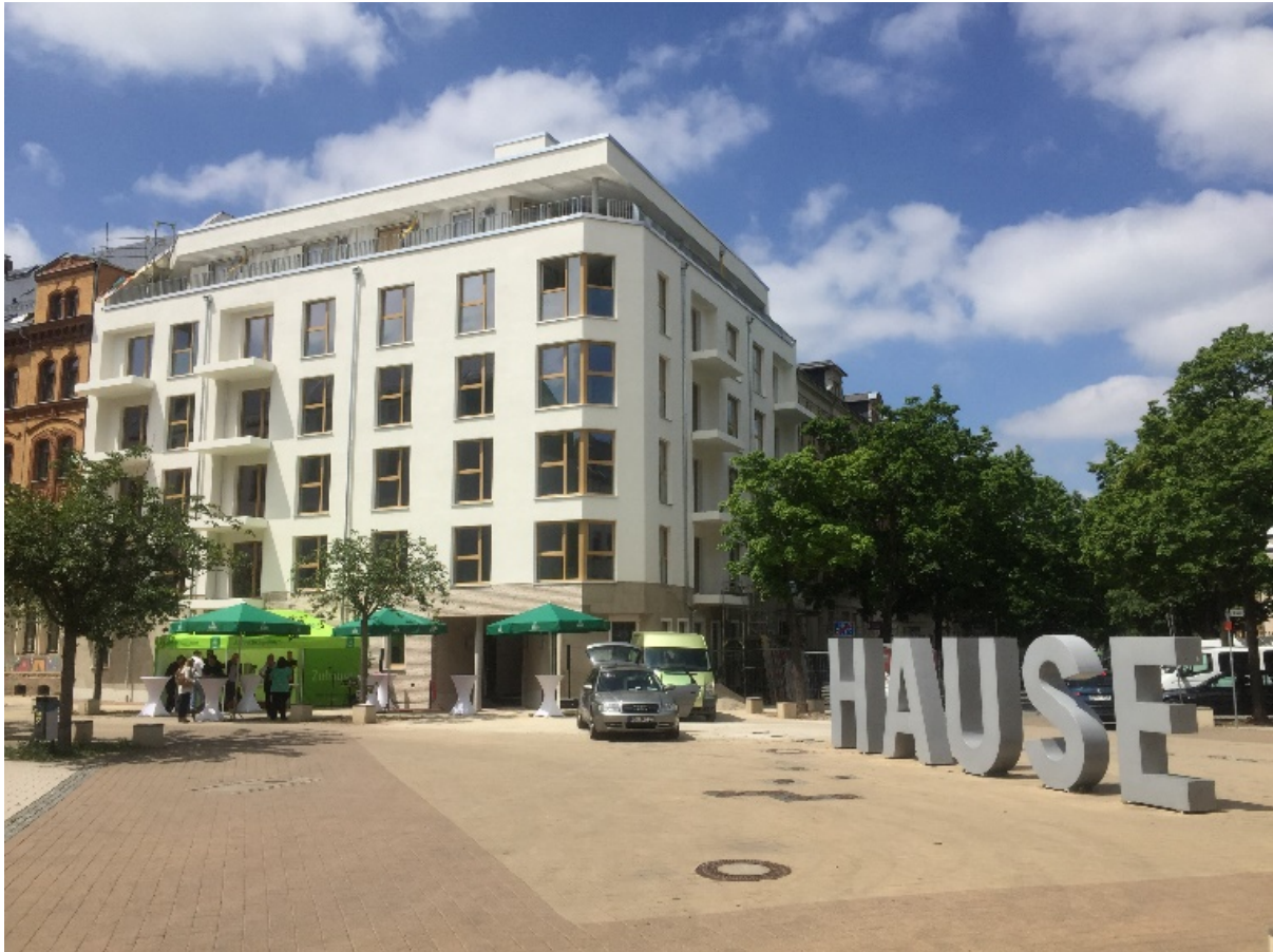
Abbildung: Fertiggestelltes Gebäude „Brühl 65“ in Chemnitz, Quelle: AIC Ingenieurgesellschaft für Bauplanung Chemnitz GmbH
