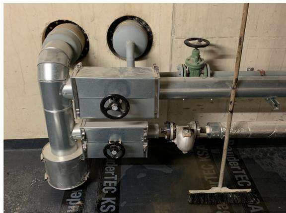
Abb.9 Fernwärmeübergabestation in BT2 (Quelle: Bauleitung Prime Value Invest GmbH)
