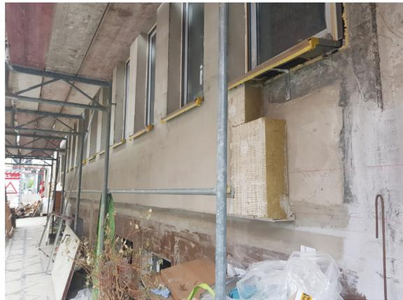
Abb.8 Wärmedämmverbundsystem an BT1 (Quelle: Bauleitung Prime Value Invest GmbH)
