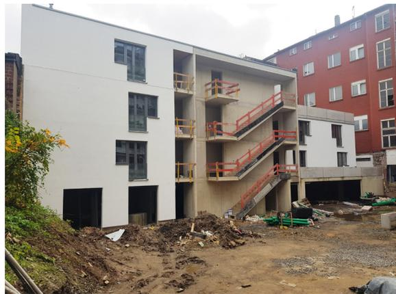
Abb.4 Verputzte Betonfassade von BT3 (Quelle: Bauleitung Prime Value Invest GmbH)
