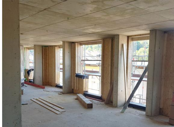
Abb.3 Tragende Stahlbetonstruktur mit vorgehängenen Fassadenmodulen in Holztafelbauweise bei BT2
