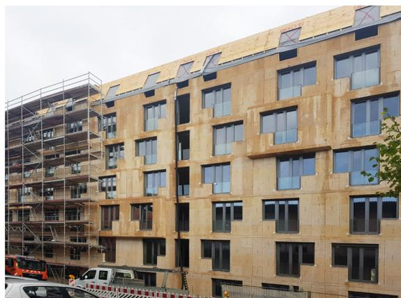
Abb.5 Fassade aus Holztafelementen von BT2 (Quelle: Bauleitung Prime Value Invest GmbH)
