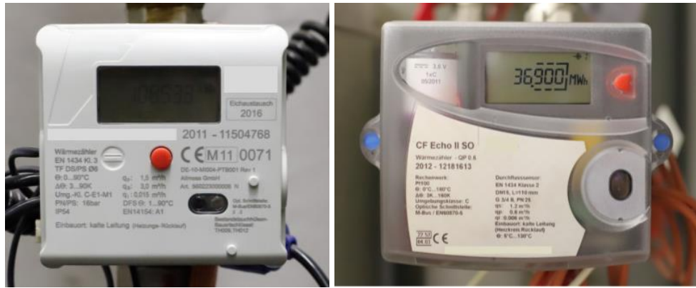
Bild 2: Zwei Beispiele von Wärmemengenzählern (Temperatursensoren nicht dargestellt).
