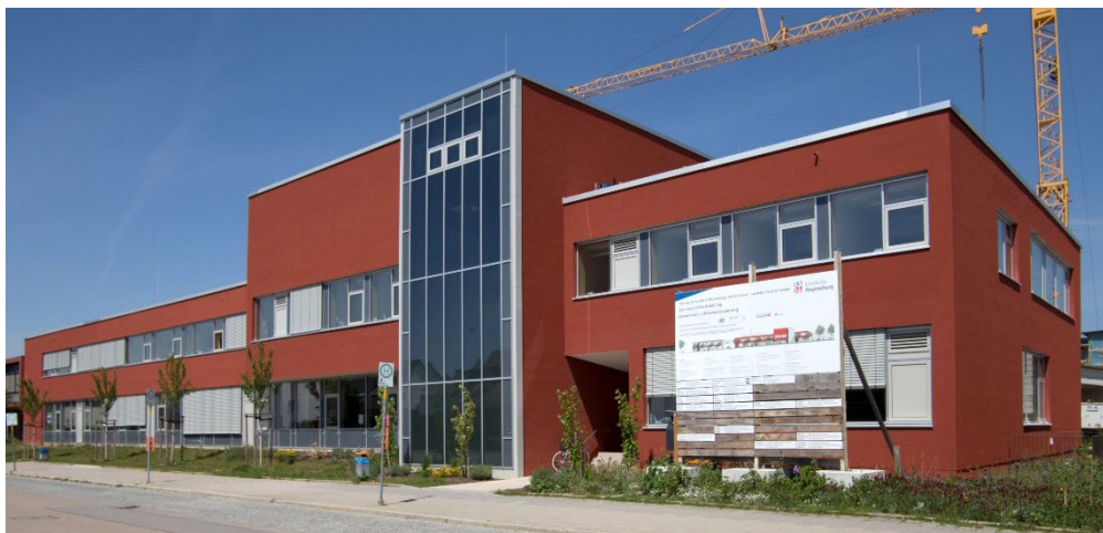
Bild 13: Teilansicht der Gebäude-Südseite [Quelle: Gymnasium Neutraubling].
