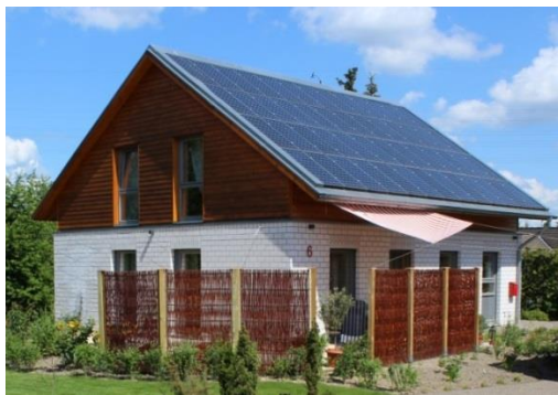
Bild 22: Anordnung der PV-Module als Indachlösung am Beispiel des Effizienzhauses Plus in Lüneburg.
