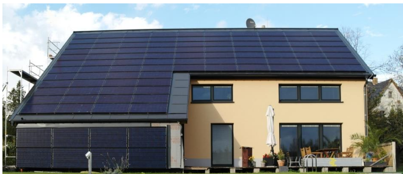
Bild 23: Anordnung der PV-Module als Indachlösung und vorgehängt vor die Fassade am Beispiel des Effizienzhauses Plus in Weifa.
