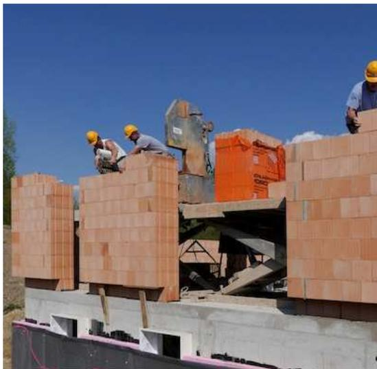
**4\_Die perlitgefüllten Poroton-Ziegel T7** in einer Wandstärke von 49 Zentimeter sind die Basis der hochwärmedämmenden und zugleich Wärme speichernden Gebäudehülle des Effizienzhauses Plus. Der Ziegel verfügt über einen Wärmeleitwert (Lambdawert) von 0,07 W/(mK) und erreicht bei der ausgeführten Wandstärke einen Wärmedurchgangskoeffizienten (U-Wert) von 0,14 W/(m<sup>2</sup>K).
