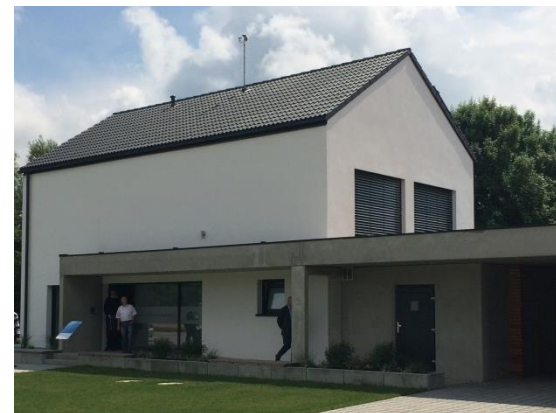
Nordansicht Effizienzhaus Plus
