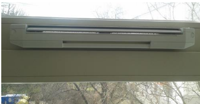
Abbildung 3: Zuluftelement im Fensterrahmen (links) und Bedieneinheit für die Nutzer (rechts).
