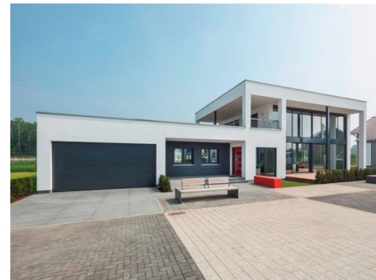
Süd-Ostansicht Effizienzhaus Plus
