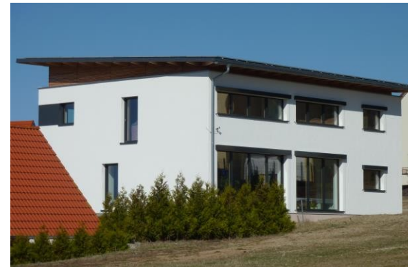
Gartenansicht Wohngebäude mit Büroeinheit
