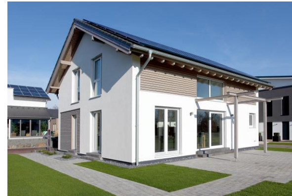
Süd-Ansicht Effizienzhaus Plus
