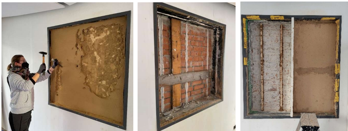
Abbildung 65: Abriss der alten Testfassaden (links), Fachwerkfassade nach dem Entfernen der alten Dämmschicht (Mitte), Ziegelfassade in der Mitte getrennt mit Abstandshaltern für die Luftschicht links und der Kork-Lehm-Plattendämmung rechts
