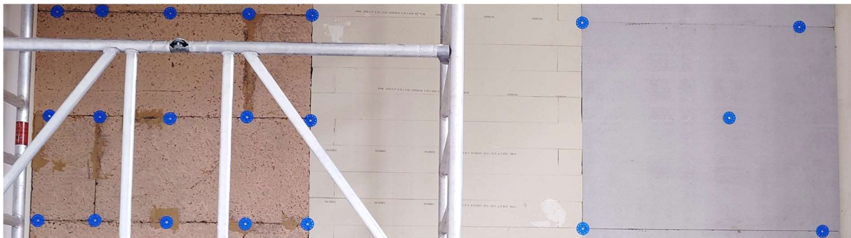
Abbildung 51: Darstellung verschiedener Plattengrößen; links: Korkdämmlehm, mittig: iQ-Therm, rechts: Kalziumsilikat
